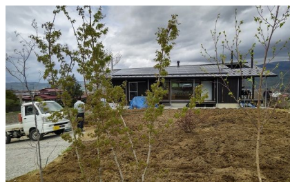
金山デッキでは植栽工事が始まっている = 2022年5月
